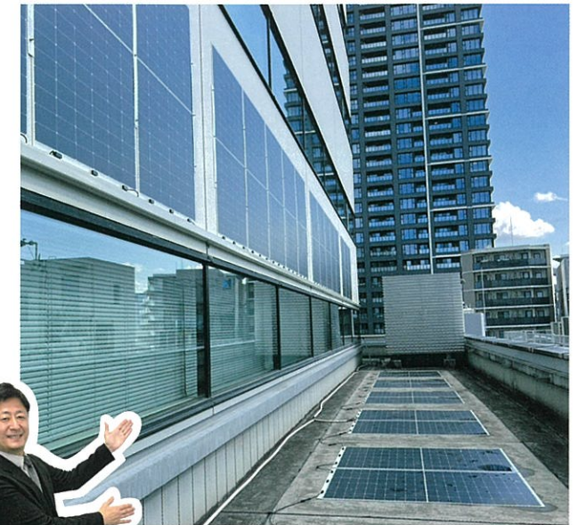
▲東京都 マルイファシリティーズ様/ 壁面: ALCボード、屋上床面: アスファルト防水
