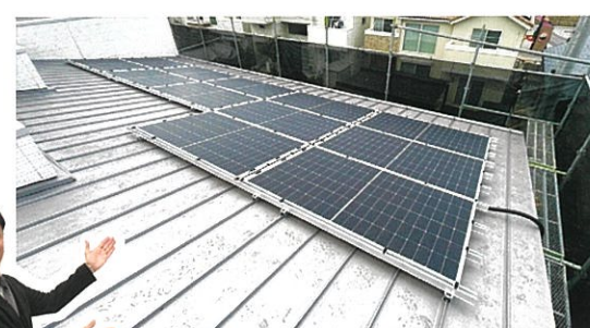
▲岐阜県W様邸/ガルバリウム鋼板屋根・架台工法
